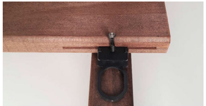
Bild 42. Der RASK-Clip muss mittig in der Ausfräsung positioniert werden.
