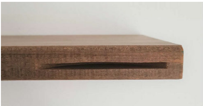
Bild 41. Die Lamello Einfräsung muss ca. 9 mm tief sein und ca. 8,5 mm von Unterseite der Diele liegen.
