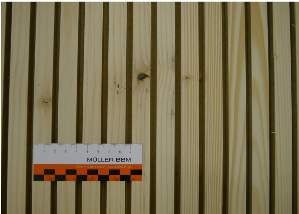
Abbildung B.2. Ansicht Schlitzbild (sichtseitig).
