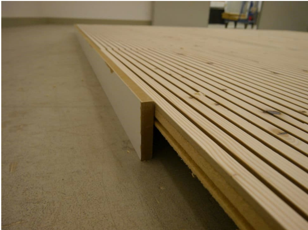
Abbildung B.5. Aufbau 2 (Typ E-100): Dielen auf einer Distanzkonstruktion über dem Boden liegend, Umfassungsrahmen teilweise montiert.
